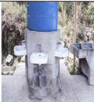
Foto 7: Sustrucción de accesorios de depósito de agua,
