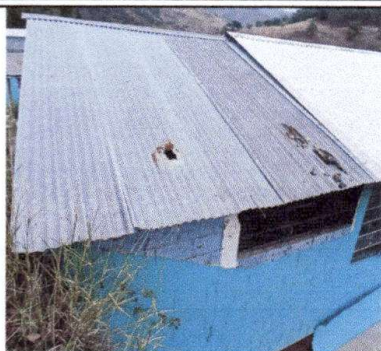
Foto 1: Cubierta de lámina
