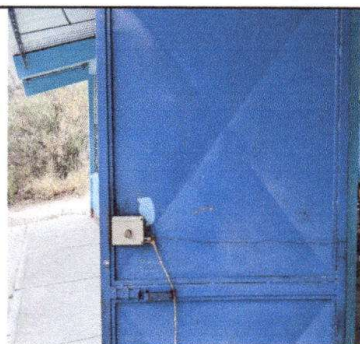
Foto 3: Sustitución de chapa
