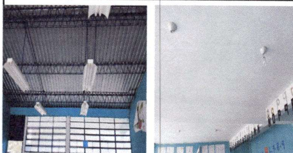
Foto 6: Reparación de sistema eléctrico
