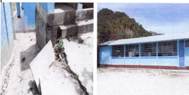
Foto 5: Reparación de plancha de concreto de patio
