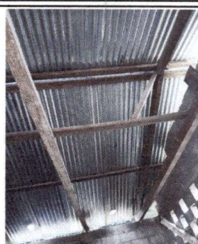
Foto 2: Sustitución de estructura de soporte de madera , por metal
