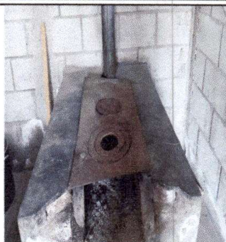
Foto 8: Sustrucción de estufa rural (completa) incluye chimenea y plancha de metal
